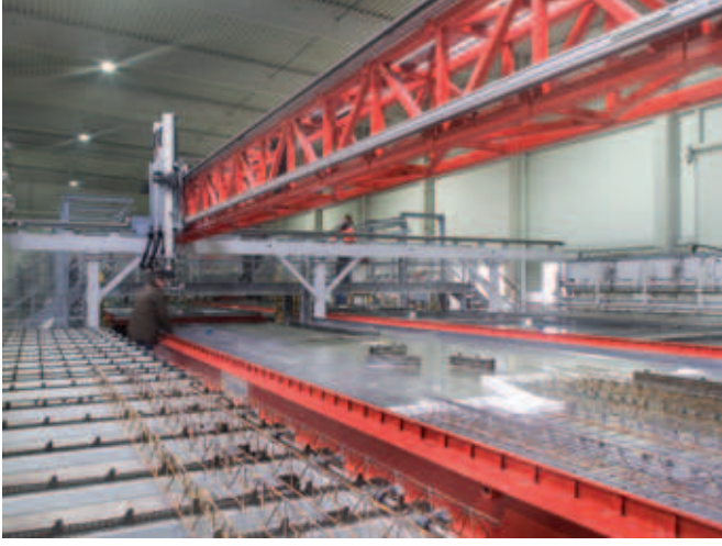
Imagen de la ejecución en dos vías de las bandejas en el área del robot para armaduras.
