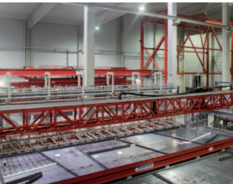
Montaje de las armaduras mediante robots de armaduras.
